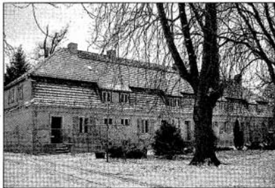
Im Gesindehaus entstehen gegenwärtig Ferienwohnungen. Die ersten sollen spätestens im Mai fertig sein.
