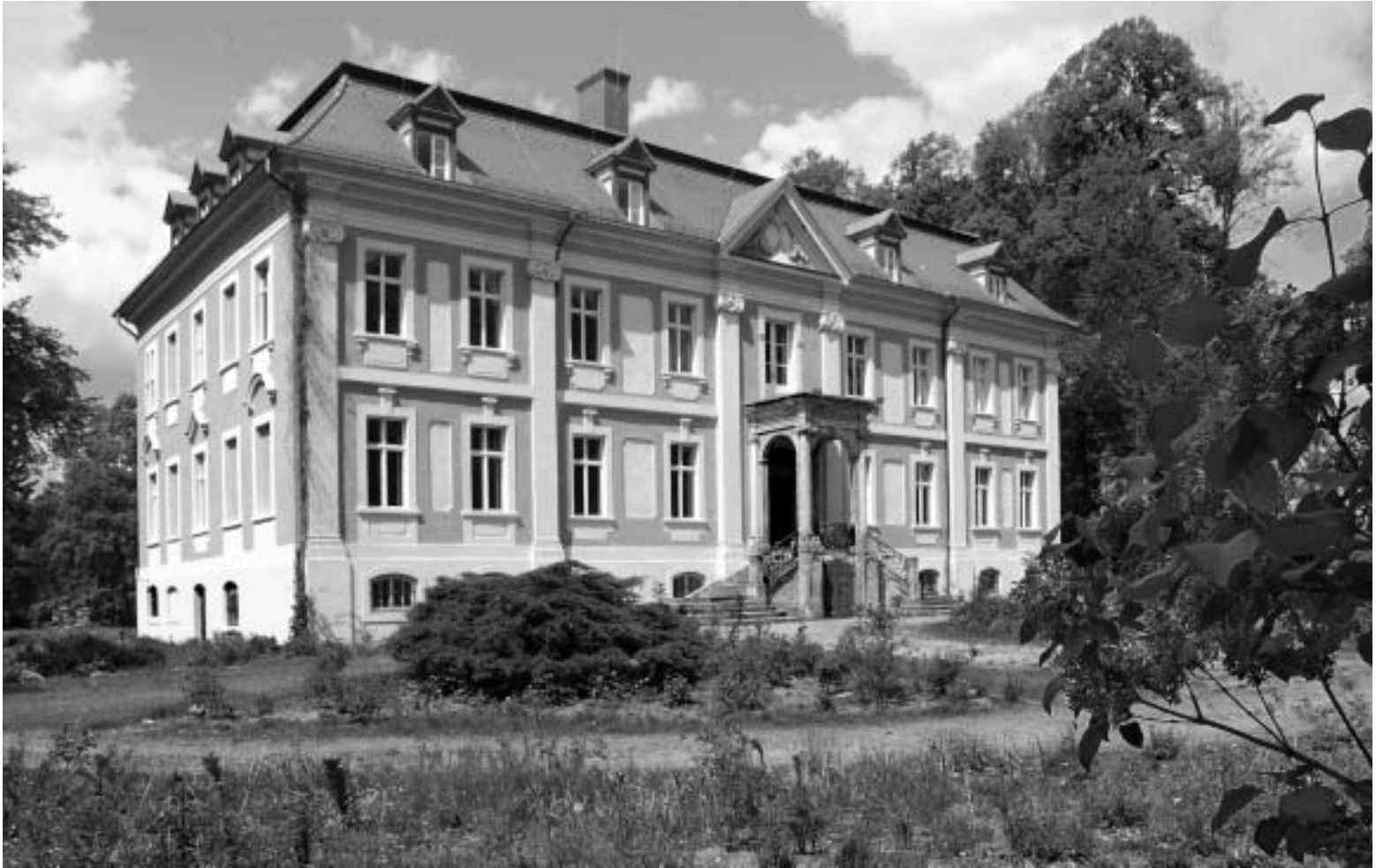
4 Herrenhaus, östliche Hof- und Eingangsseite. Aufnahme 2009
