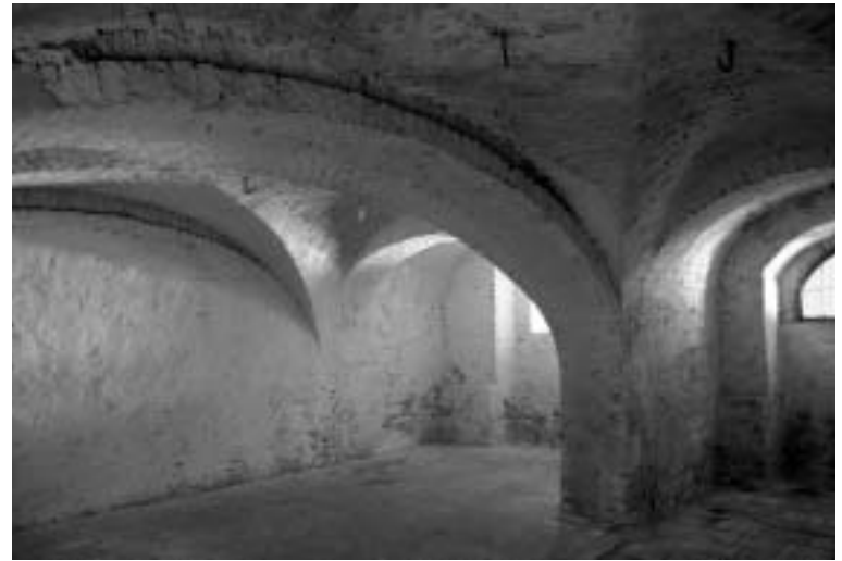
11 Keller mit Kreuzgratgewölbe. Aufnahme 2009
