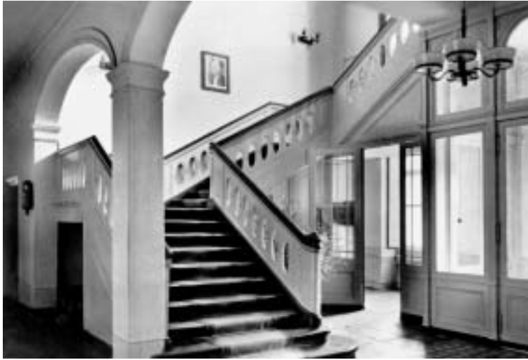
12 Vestibül mit Treppenhaus. Aufnahme 1963
