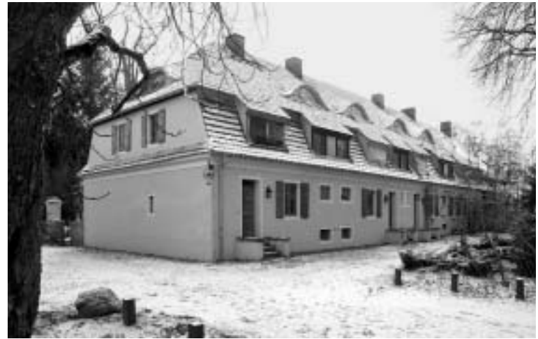
20 Ehemaliges Bedienstetenwohnhaus an der Südostecke der Hofanlage. Aufnahme 2009
